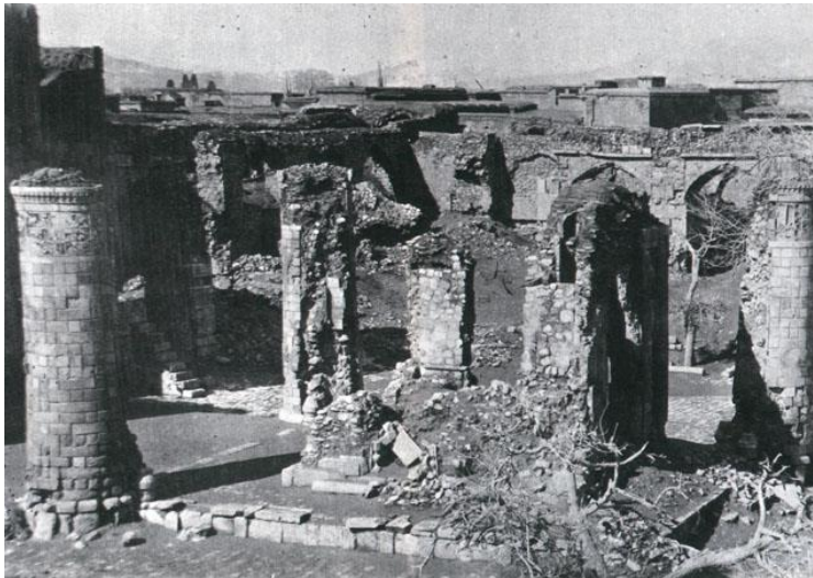
تصویر ۱۸. وضعیت خدای‌خانه در سال ۱۳۱۳ش که ویلبر عکس آن را انداخته. جز خرابی‌های فراوان، نسبت به زمان دیدار دیولافوا، برج کنج شمال شرقی فرو ریخته است (Wilber, 1972: 40)
